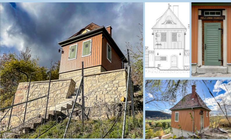
Sanierung historisches Weinbergshaus, Naumburg (Saale) Gebäude und Freianlagen, Instandsetzen und Wiederherstellen nach historischen Unterlagen, innen und außen Bestandsaufnahme, Vorentwurfs-, Genehmigungs- und Ausführungsplanung, Vergabe, Bauüberwachung
