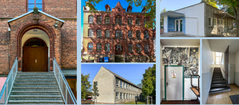
Umbau und Modernisierung Pestalozzi-Schule, Hohenmölsen mit denkmalgeschütztem Hauptgebäude, Kabinettsgebäude und Latrine Objektplanung Gebäude und Brandschutzkonzept Bestandsaufnahme, Partizipationsverfahren
