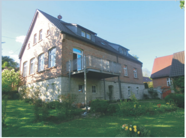
Anbau eines Balkons, »Alte Schule« Lengefeld Neue Fassadenöffnung, Stahlbalkon, Beleuchtung
