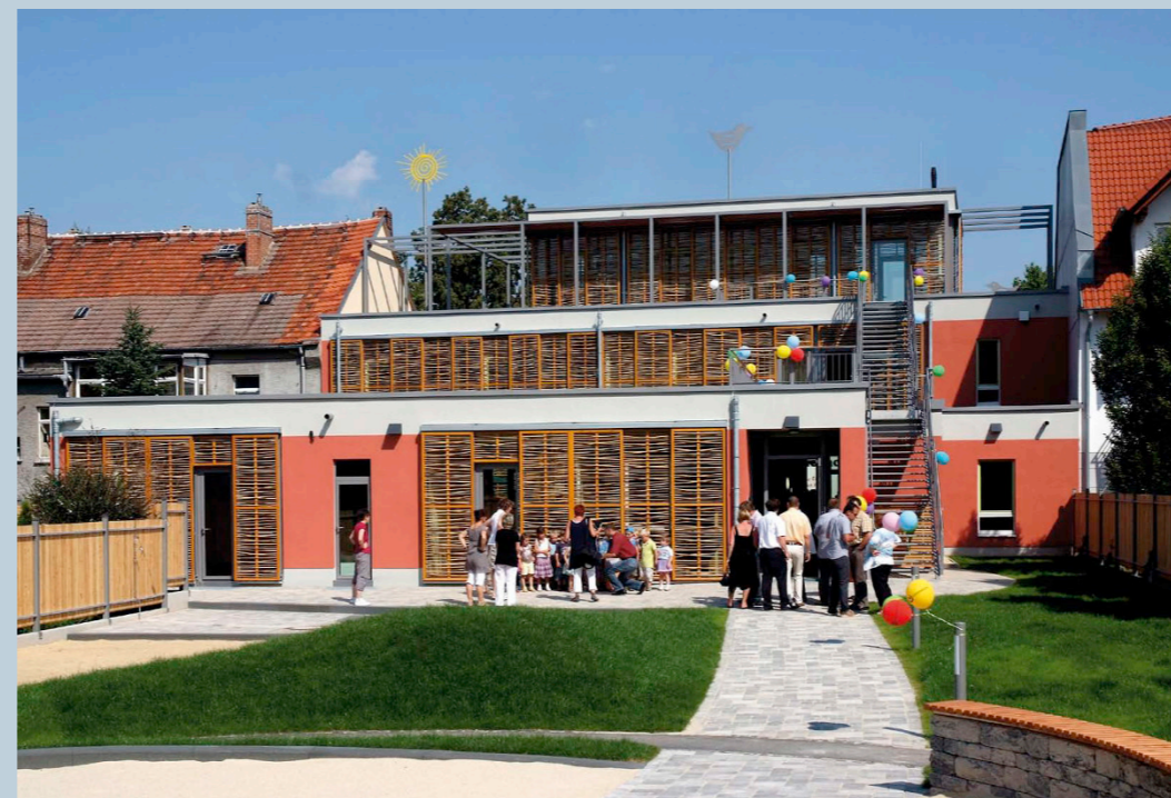
Neubau Kinderkrippe »Domspatz« in Naumburg Gebäude und Freianlage Nestverschattung, Dachskulpturen, Gründach, Erdwärme, Regenwassernutzung
