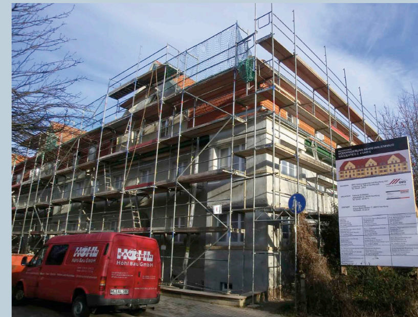
Mehrfamilienwohnhaus im Gartenstadtcharakter Instandsetzung und Modernisierung
