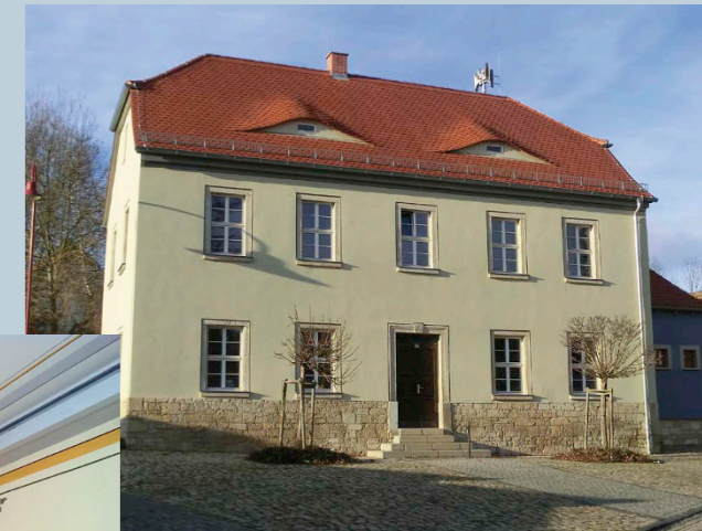
Weingut in Roßbach Instandsetzung und Modernisierung Haupthaus und Saalgebäude Wandbemalungen, Stuckdecken, Sanierung historischer Bestand
