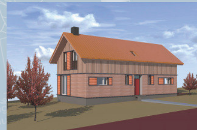
Neubau Einfamilienhaus in Naumburg Niedrigenergiehaus, Bauweise massive Holzmauer (MHM)
