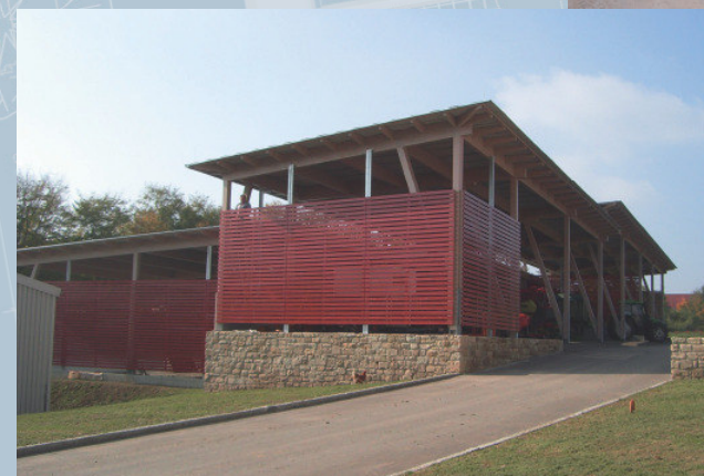
Neubau Carport für Landmaschinen und Technik in Naumburg Holzbauweise, verdeckte Befestigungsmittel, eingespannte Stützen
