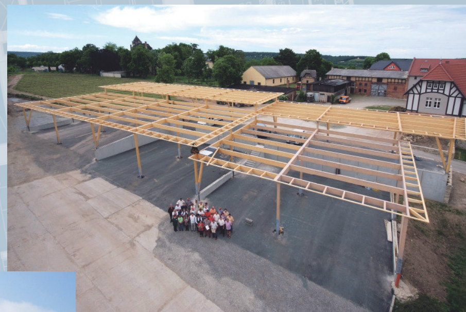
Neubau Carport für Landmaschinen und Technik in Naumburg Holzbauweise, verdeckte Befestigungsmittel, eingespannte Stützen
