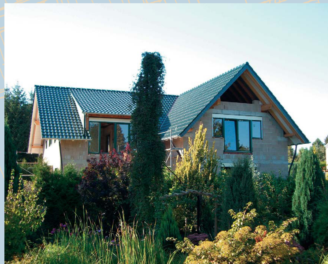
Strohballen-Gartenhaus in Naumburg Neubau: Strohballen d=55cm, Lehmputz; Dachziegel und Fachwerk in Wiederverwendung
